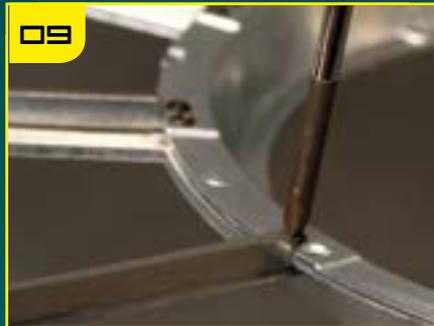
Закрепите раму BF-35, закрутив один винт в кольцо турели и зафиксировав конец ребра жесткости.
